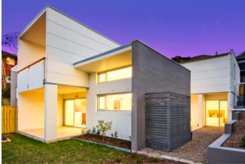
Arkitekttegnet hus med lameller til krydsventilation, der udnytter kølige briser fra havet Manly Beach, Sydney, Australien
